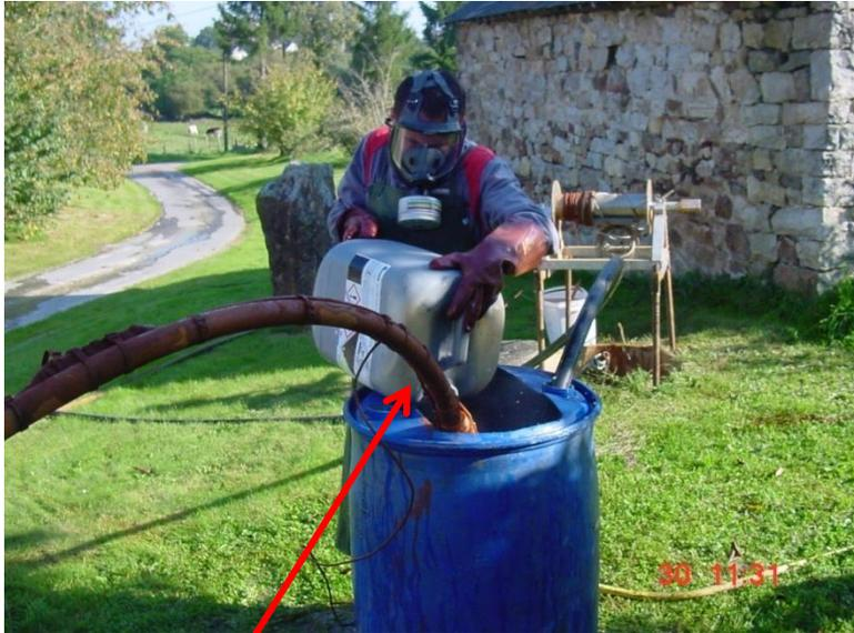
Solubilisation des oxydes de fer à l'acide chlorhydrique en circuit fermé
