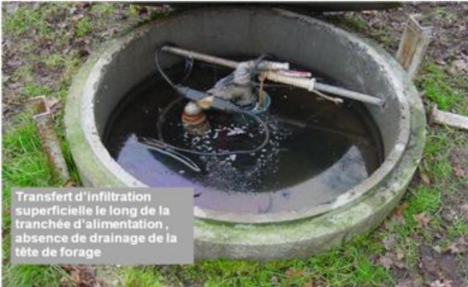
Transfert d'infiltration superficielle le long de la tranchée d'alimentation, absence de drainage de la tête de forage
